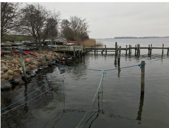
Foto nr. 3 Havnen set mod nord, hvor den nye havneudvidelse skal etableres
