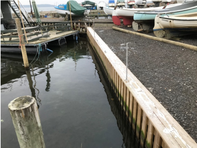
Foto nr. 1 Selvbygget bolværk mod den gamle havn
