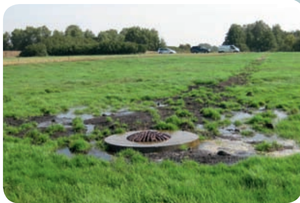
Eksempel på overrislingsbrønd Example of an irrigation well
