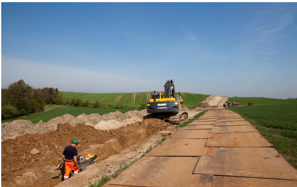
Figur 27 Eksempel på arbejdsbælte med afrømmet rå- og muldjord samt køreplader. Bemærk, at dette er et tracé med et kabelsystem.
