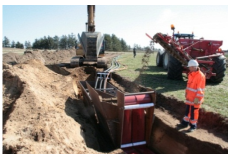
Figur 29 Kabellægning med gravekasse
