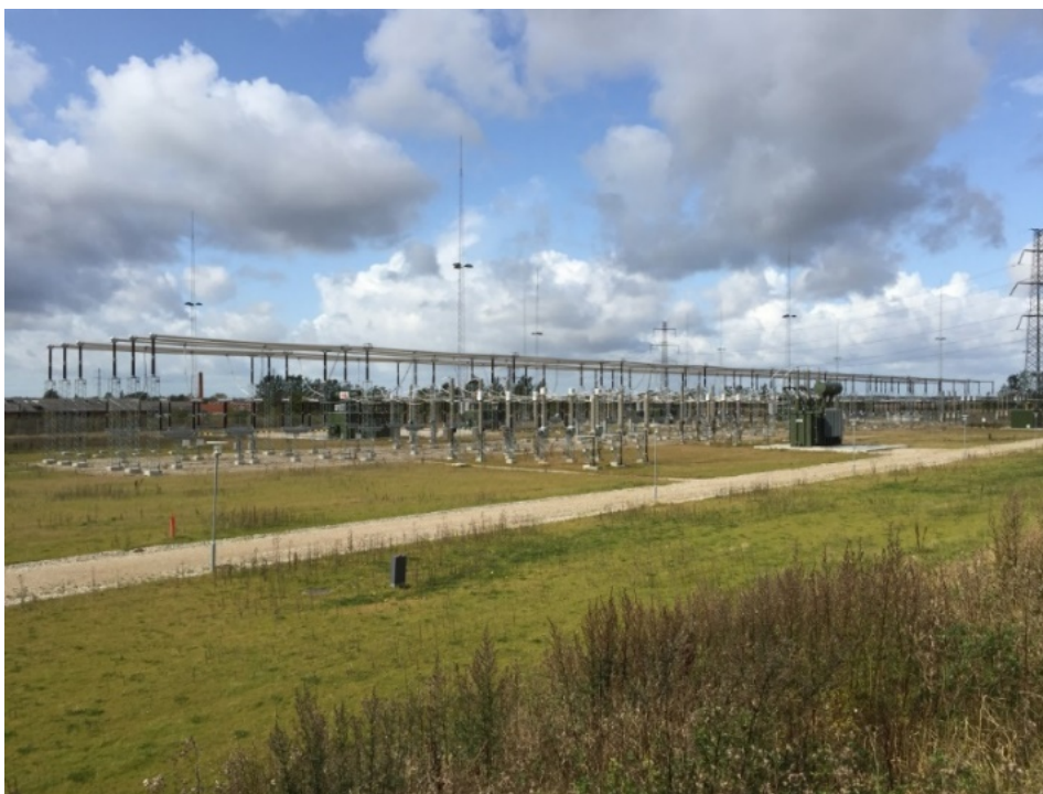
Figur 9 Eksempel på en åben 220 kV AIS-station.
