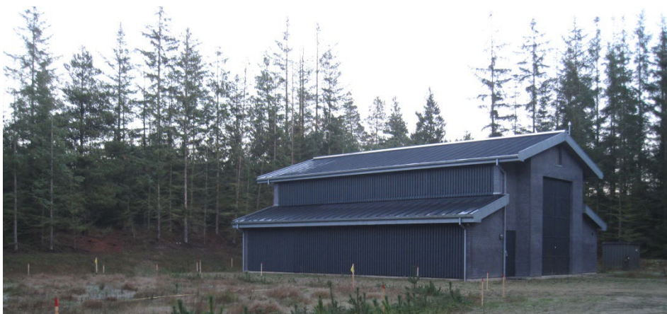
Figur 21 Eksempel på en bygning indeholdende et gasisoleret kompakt indendørs koblingsanlæg (GIS) samt en kompenseringspole (Blåbjerg). Ved større anlæg placeres kompenseringspoler normalt i egne bygninger.
