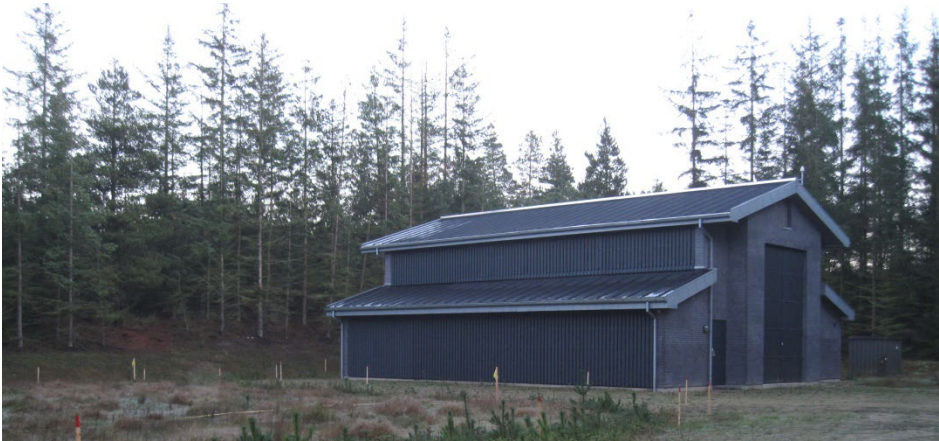
Figur 6 Eksempel på en GIS-station placeret i en lukket bygning (Blåbjerg).
