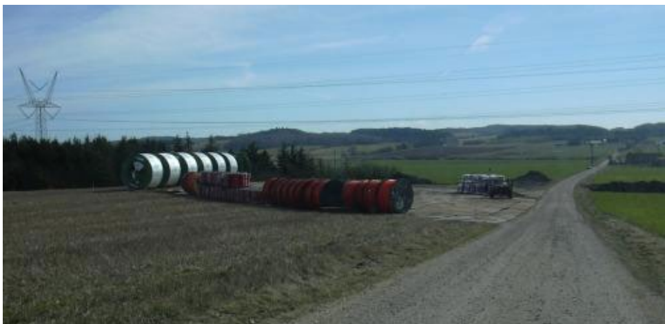
Figur 32 Eksempel på tromledepot.
