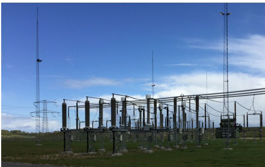
Figur 14 Eksempel på et felt (station Endrup).
