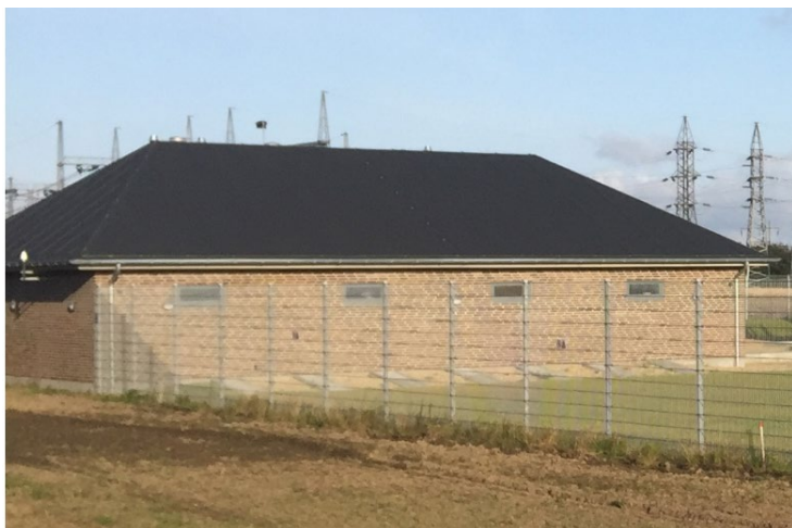
Figur 13 Eksempel på en AC-stationsbygning. (Roslev) Bygningen er modulær, og forlænges efter antallet af felter på stationen
