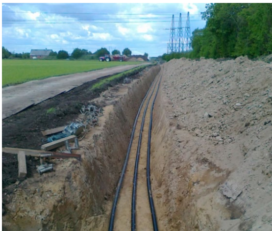
Figur 28 Eksempel på en kabelrende lige efter udtrækning af kabler.
