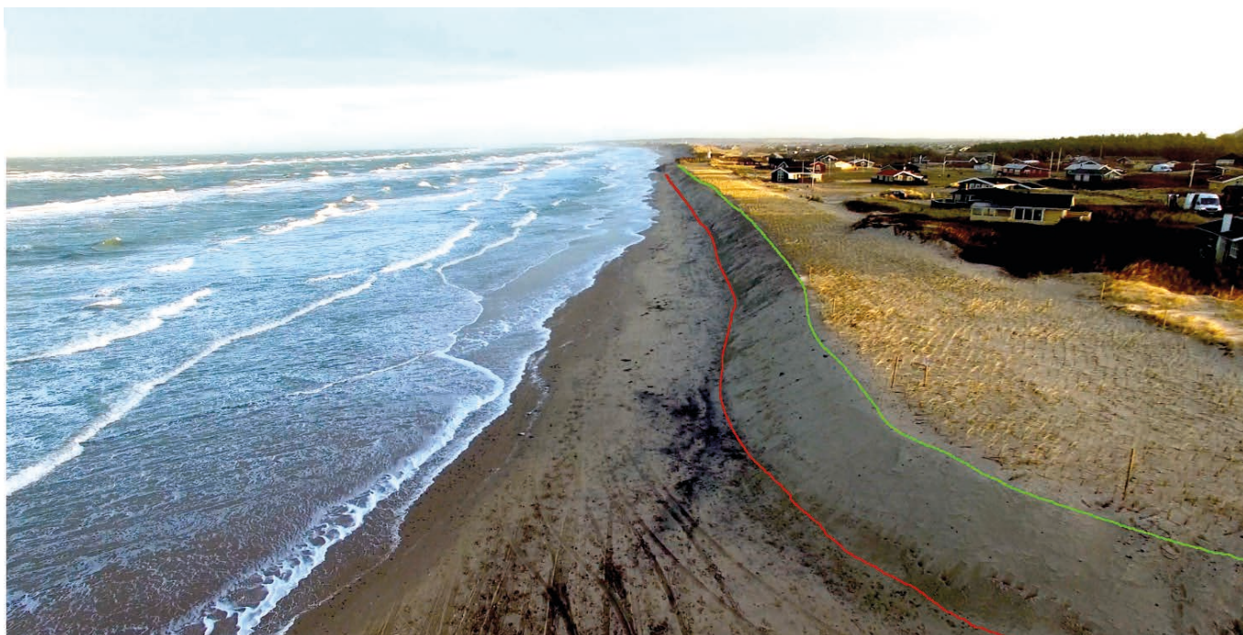
Figur 4 Strandfodring ved Nørlev Strand som en naturlig buffer foran en skråningsbeskyttelse. Grøn streg er top af fodring, rød streg er ny skræntfod efter fodring.
