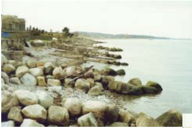
Ukoordinerede høfde- og skræntbeskyttelser.
