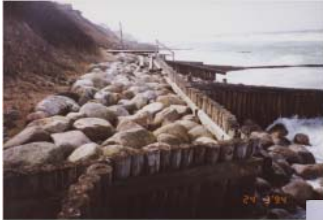
Ingen strand foran skræntbeskyttelsen, og høfderne kan ikke fastholde en strand.
