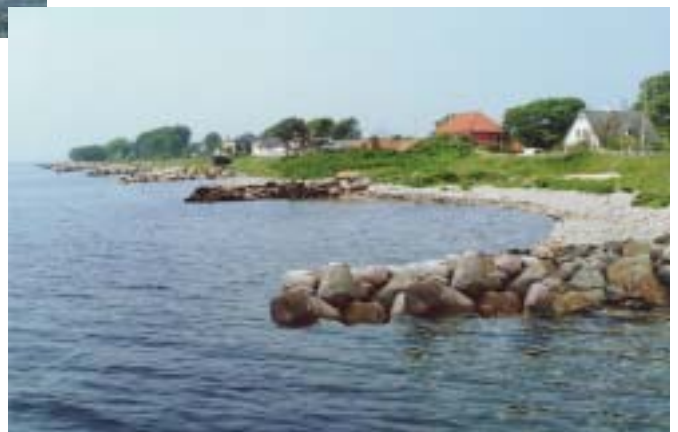
Høfdesystemet omlægges til færre og længere høfder med en mindre højde.
