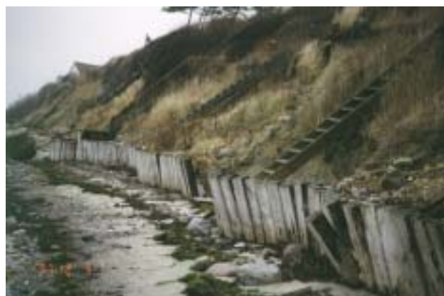
Slidt skræntbeskyttelse af træpæle. Strand foran
