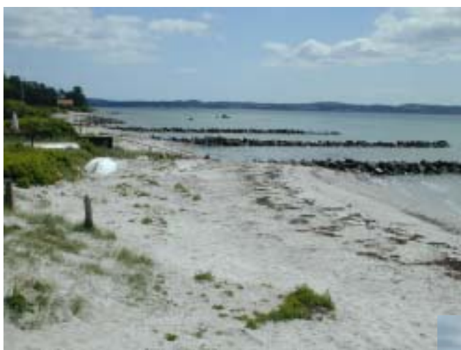
Der er etableret lange høfder på læsiden af en mole, hvilket har flyttet erosionsproblemet længere hen på kysten.
