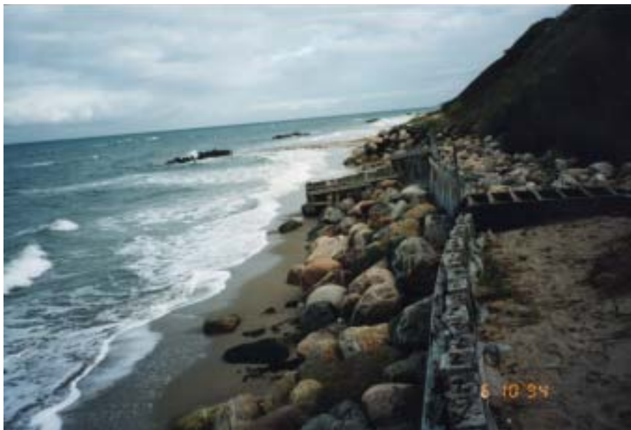
Uharmonisk skræntbeskyttelse, ukoordinerede bølgebrydere og smal strand.
