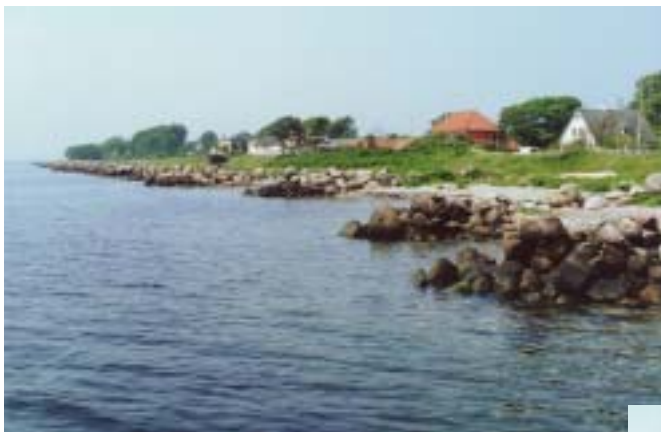
Mange tætliggende og uharmoniske høfder.
