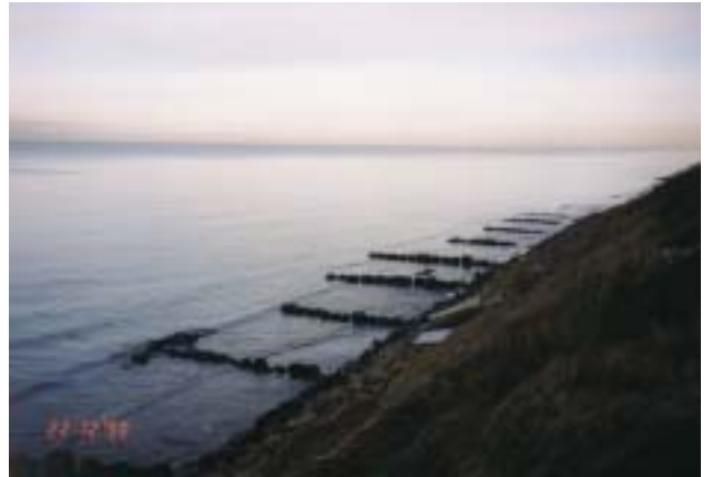
Hølfer uden stabiliserende virkning
