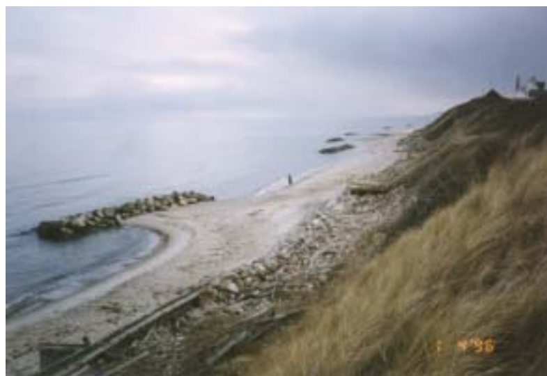
Velfungerende bølgebrydere. I baggrunden fungerende bølgebrydere
