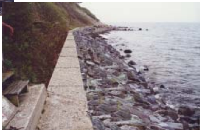
Der kan i forbindelse med etablering af en effektiv stenkastning samtidigt etableres passagemulighed på skræntbeskyttelsens krone. Her er stien opbygget af tunge betonblokke.
