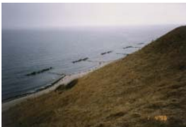
Dårlig projektering (Bølgebryderne har kun svag virkning, da der er bygget for spinkle)
