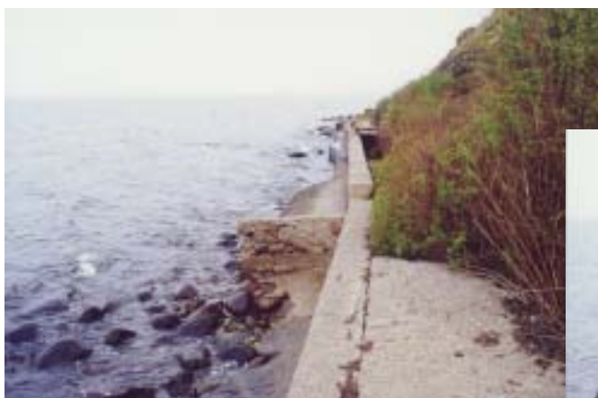
Forslag til renovering af forstærkning af skræntbeskyttelsen ved etablering af en stenkastning, og samtidig etablering af passagemulighed på kronen.
