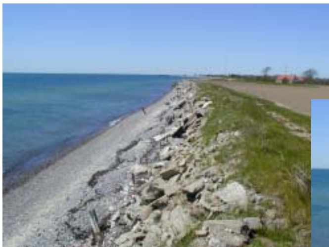
Betonbrokker anbragt som „skræntbeskyttelse“.
