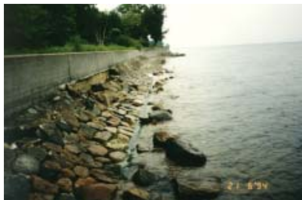
Betonmur som skræntbeskyttelse. Muren beskyttet af en stenkastning mod underminering
