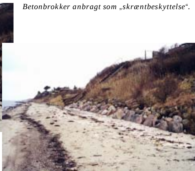
Betonbrokker fjernes, og der anlægges en stenkastning.
