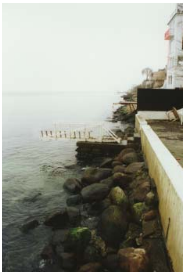
Eksempel på kyst, hvor stranden er borte-roderet foran skræntbeskyttelsen.
