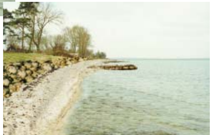
Eksisterende beskyttelse kan fjernes og erstattes af et samordnet system med skræntbeskyttelse og høfder.
