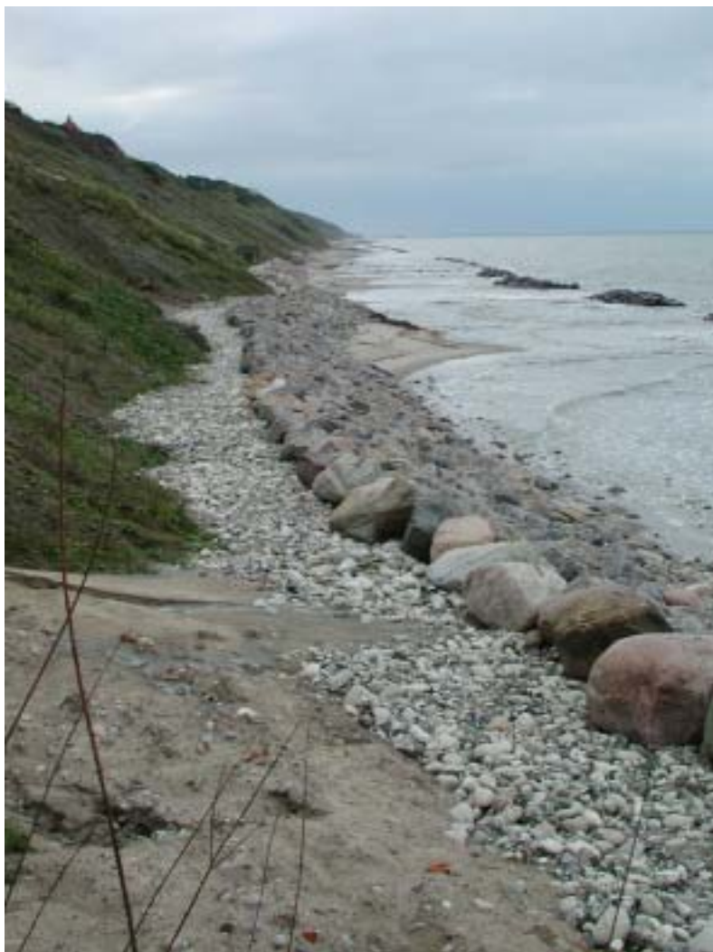
Eksempel på samordnet renovering af nedslidte skræntbeskyttelser. Ved renoveringen er der etableret en stipassage bag skræntbeskyttelsens krone.
