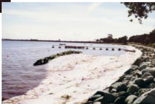
Skræntbeskyttelsen renoveres, der foretages en bypass-fodring med sand fra havnens luvside og der etableres en bølgebryder for at fastholde fodringssandet.
