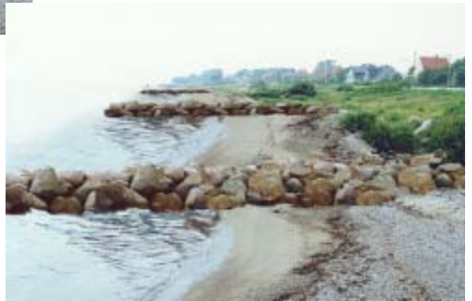
Skræntbeskyttelse anlagt unødvendigt dominerende og fremrykket på kysten.
