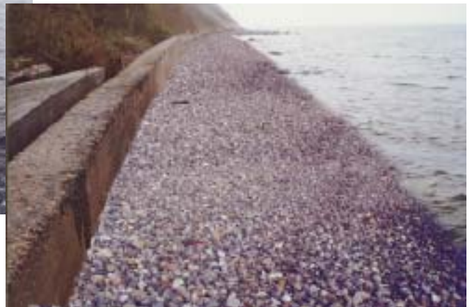
Der kan fodres med ral, så underminering forhindres og passage er mulig.
