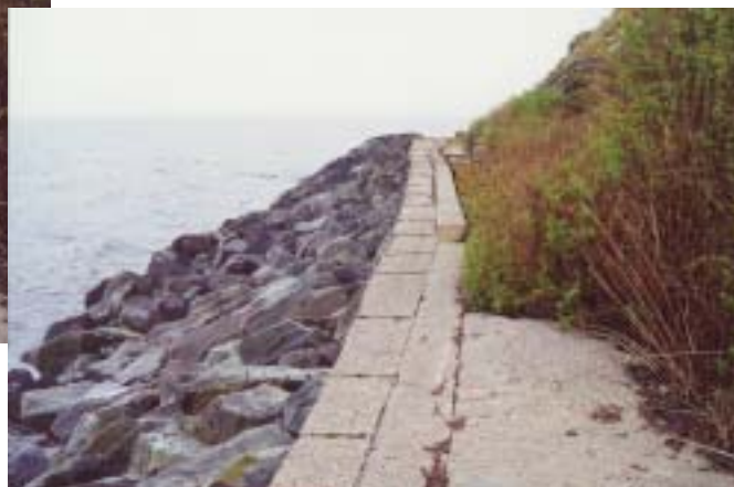
Forslag til renovering af forstærkning af skræntbeskyttelsen ved etablering af en stenkastning, og samtidig etablering af passagemulighed på kronen.
