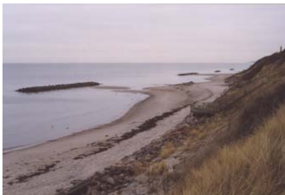
Kystens udseende efter at der er strandfodret og anlagt et nyt system af bølgebrydere.
