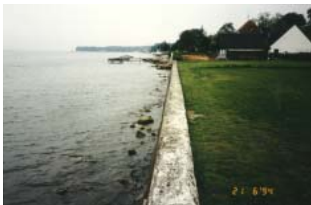
Betonmur som skræntbeskyttelse. Ingen strand foran
