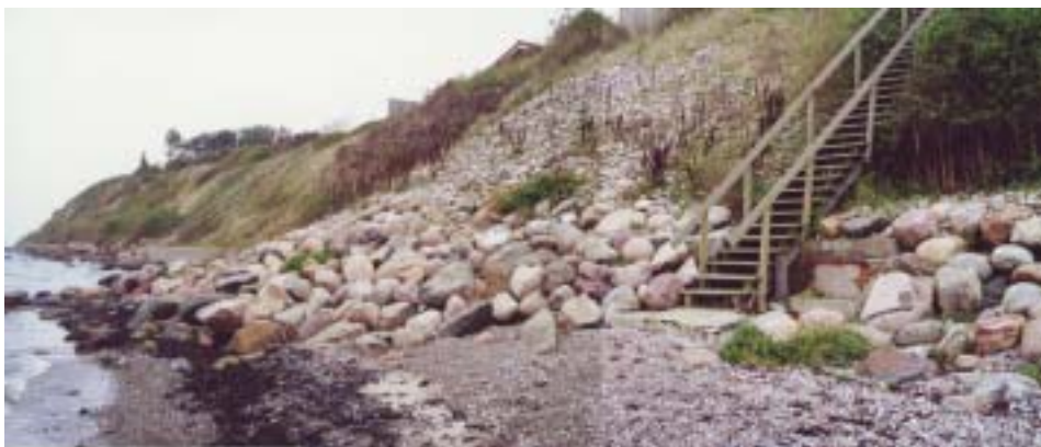
Skræntbeskyttelse anlagt unødvendigt dominerende og fremrykket på kysten.
