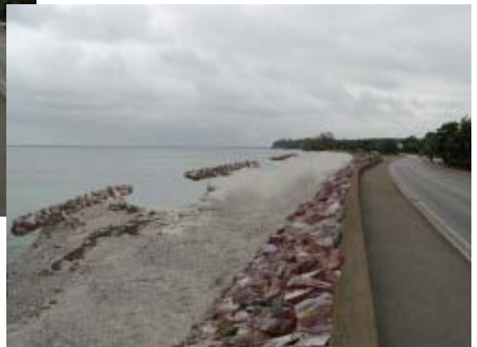
Kystens forventede udseende efter renovering af skræntbeskyttelsen, udførelse af strandfodring og etablering af bølgebrydere.
