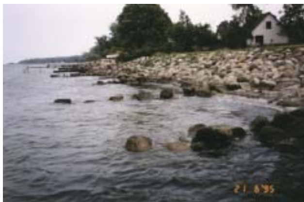
Skræntbeskyttelse af sten. Ingen strand foran
