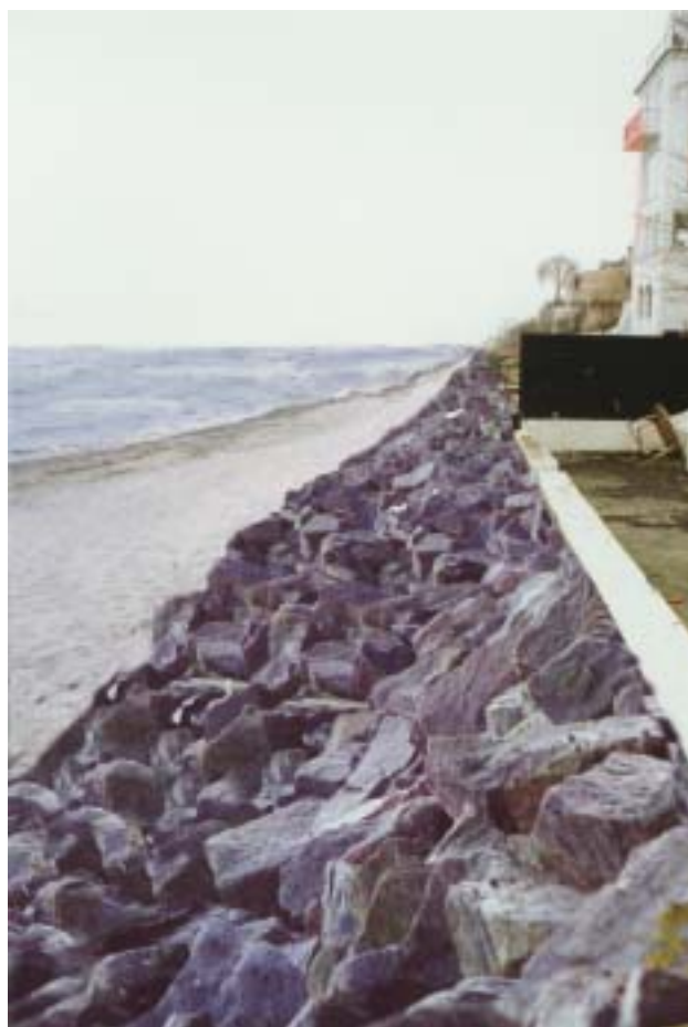
Eksempel på, hvordan skræntbeskyttelse kan renoveres, så risiko for underminering fjernes, og passage langs kysten kan foregå på indpumpet sandstrand.
