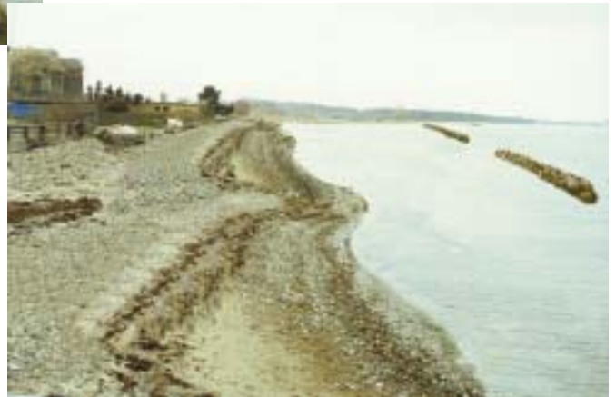
Høfderne kan fjernes og der kan f.eks. etableres store bølgebrydere for at stabilisere kysten.
