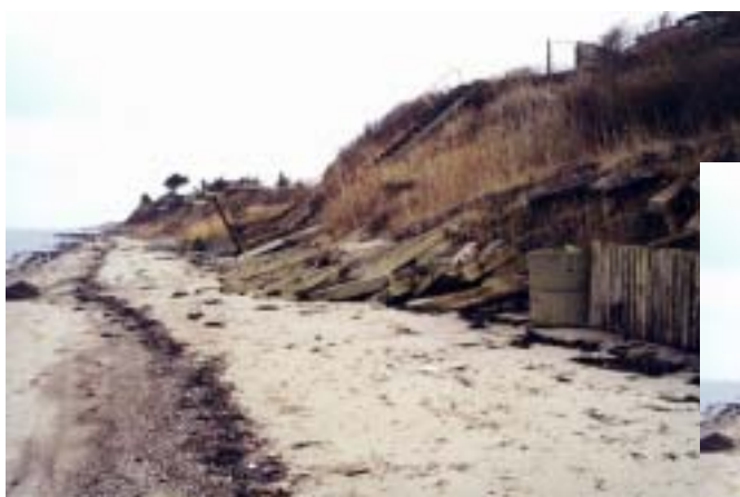
Betonbrokker fjernes, og der anlægges en stenkastning.
