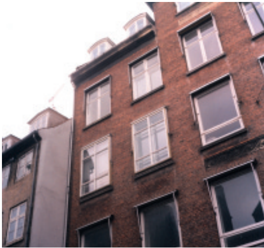
De 2 prototypevinduer i Store Strandstræde 9. Bemærk: Vinduet er endnu ikke helt tilpasset facaden. En fuldt færdig version vil ligge i plan med de oprindelige vinduer.
