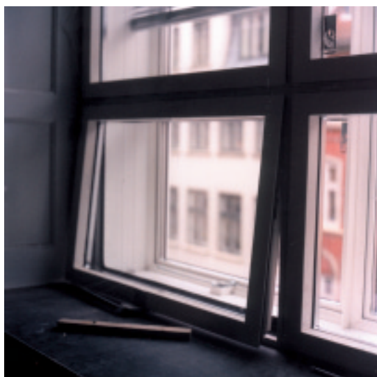
Vindue 1, uden akustisk dæmpning imellem glassene. Glassenes indbyrdes afstand er ca. 25 cm. i begge prototyper.
