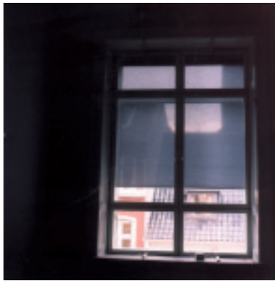
Vindue 1 - det tættest Kgs. Nytorv - med halvt nedtrukket rullegardin
