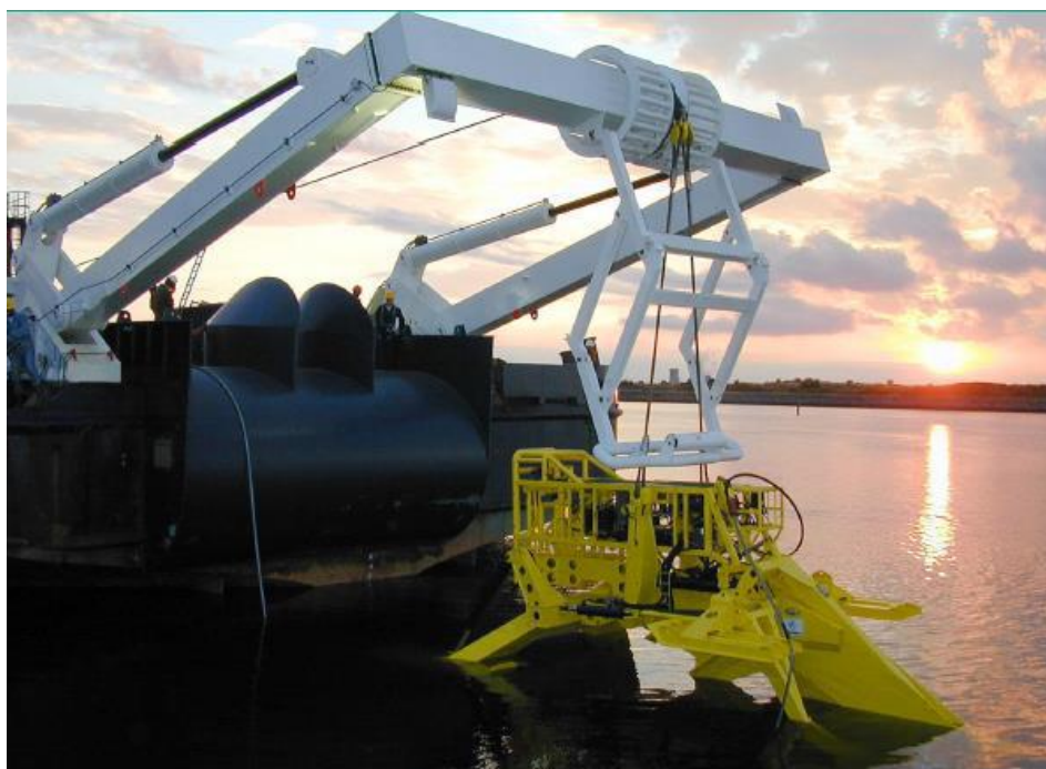
Figur 1.4: Foto af "Sea Stallion"-kabelplov, der skal nedpløje søkablet (JD-Contractor A/S, 2019c)
