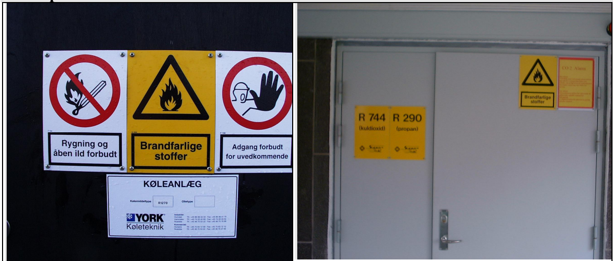
Mærkning af dør til maskinrum med kulbrintekølemidler.
