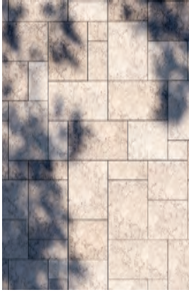
Belægning i glasgang og udearealer
