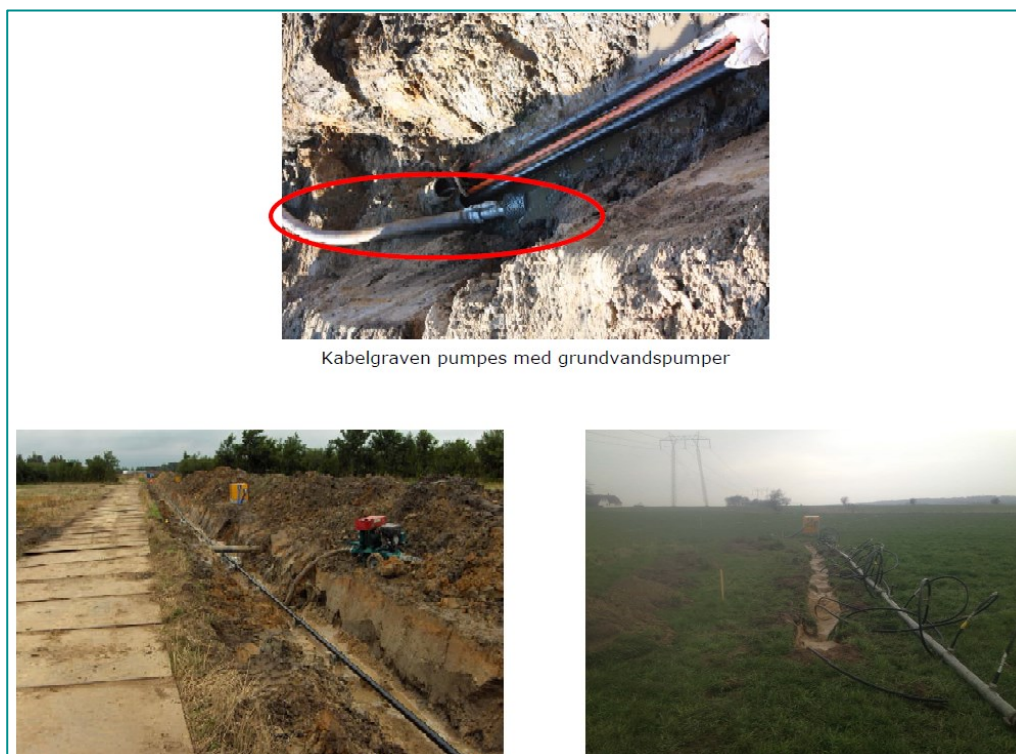
Figur 2-7 Forskellig metoder til at holde kabelgraven tør. På billedet til venstre etableres drænrør, til højre etableres sumpspidsanlæg
