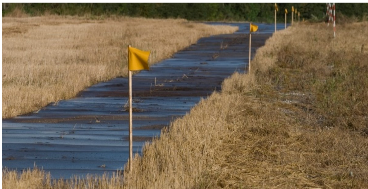
Figur 2-10 adgangsvej med køreplader
