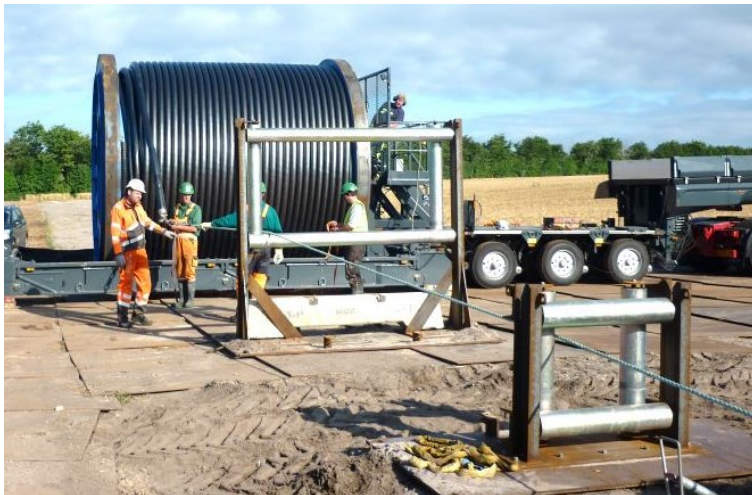
Figur 2-44 Kabeltromle på blokvogn
