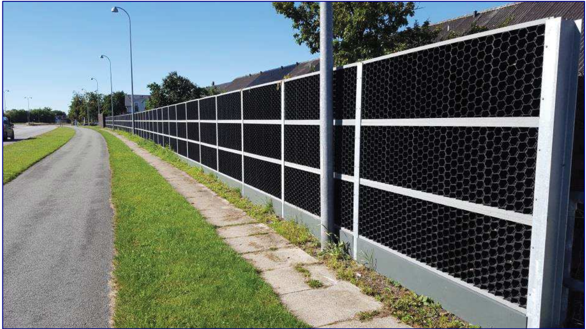
Figur 11. Eksempel på støjskærm langs et boligområde. De sorte akustiske elementer i skærmen består af materiale fra genbrugte vindmøllevinger (Vallensbæk).
