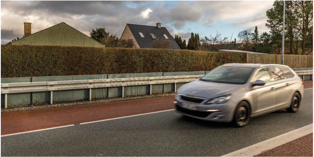
Figur 13. Autoværn, der er udformet som en lav støjskærm. Selvom skærmen er lav, kan der være en støjdæmpende virkning, fordi den står meget tæt på støjkilden (Vejlegårdsvej, Vallensbæk Kommune).
