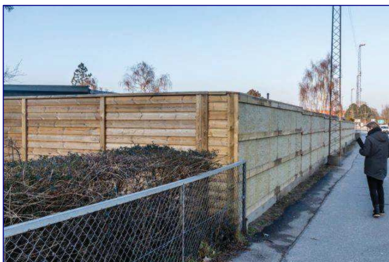
Figur 22. Her har grundejeren bygget sit eget støjhegn og brugt mineraluld på siden mod vejen. Hegnet har formentlig en god støjdæmpende virkning fordi det er tæt, har en god højde og går op i skel vinkelret på vejen. Mineralulden har ingen betydning for hegnets støjdæmpende virkning hos grundejeren.
