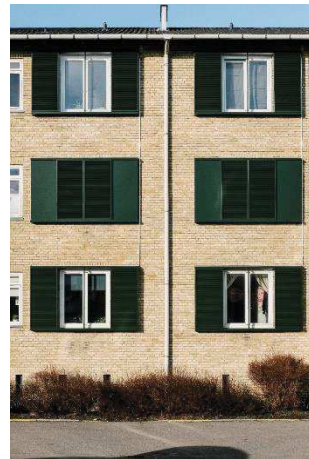
Figur 18. Støjdæpende multifunktionsvindue (billederne til venstre og i midten). Støjen dæmpes på vejen gennem åbningen for neden (udendørs) til åbningen for oven (indendørs). Til højre er vist en lydskodde, som er monteret foran et eksisterende vindue. Den dæmper støjen, men giver også adgang for frisk luft. Den kan desuden mørkelægge et rum, hvis det ønskes.
