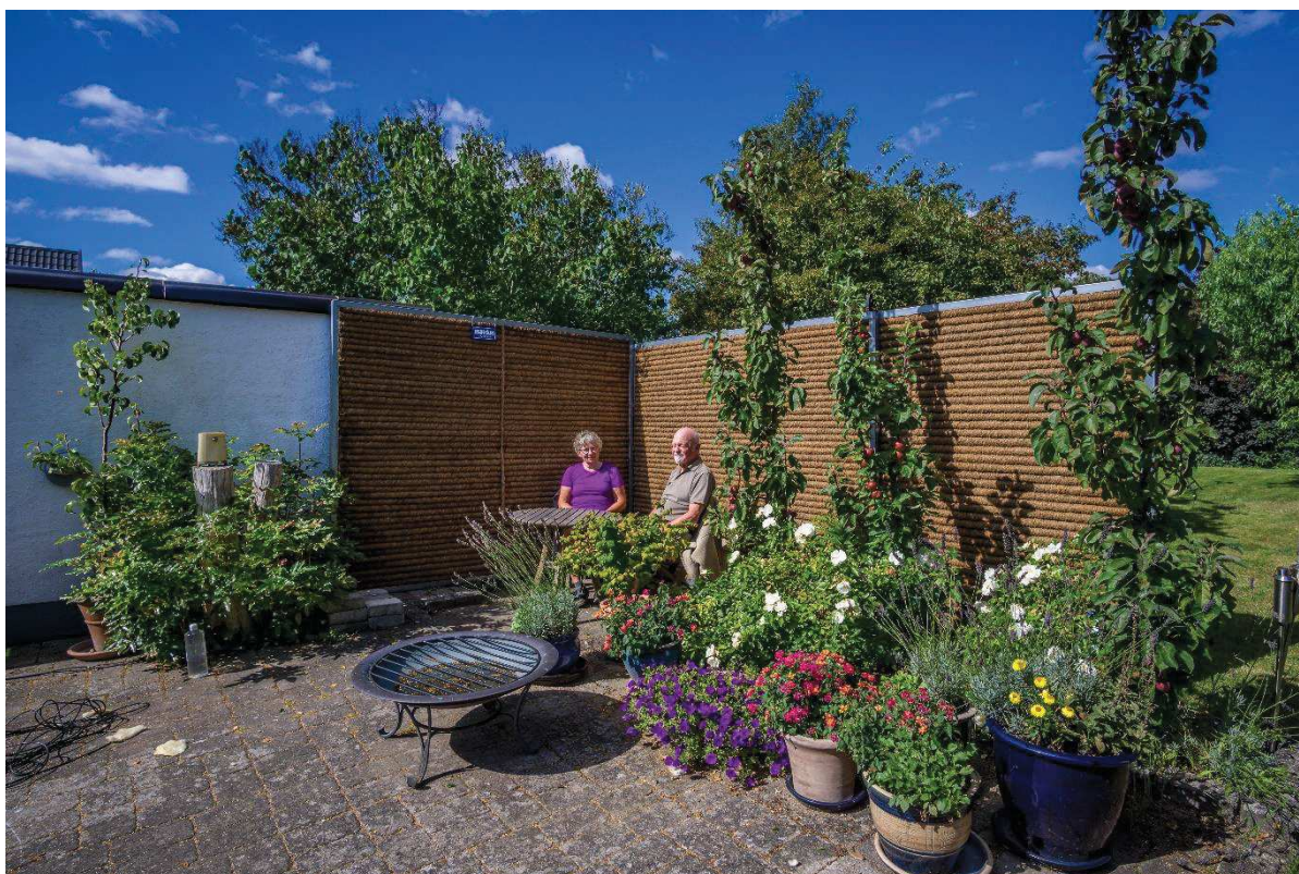
Figur 21. Et støjhegn kan skabe en støjfaskærmet krog eller terrasse. Den støjdæmpende virkning kan opleves i et mindre område lige op af hegnet (fra en forsøgsopstilling i en have i Glostrup).
