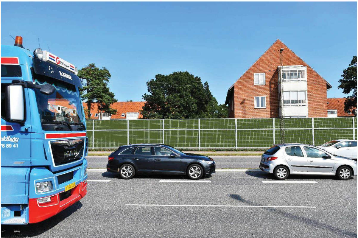
Figur 14: Eksempel på støjskærm ved et etageboligområde. Støjskærmen dæmper støjen på de udendørs opholdsarealer bag skærmen og for boligerne i stueetagen, men ikke for boligerne på 1. og 2. sal.
