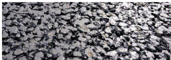
Figur 10. Nærbillede af et nyt og mindre støjende slidlag (teknisk betegnelse: SMA-8). Både den meget jævne og åbne overfladestruktur ses tydeligt. En traditionel belægning (f.eks. SMA-11) har en grovere og mere ujævn struktur.
