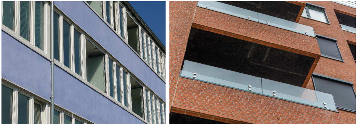
Figur 19. I ejendommen til venstre blev altanerne forsynet med en forsatsrude, der kan skydes til siden. Når ruden er lukket, fungerer den sammen med altanrummet som en meget effektiv støj dæmpning. Til højre er vist åbne altaner med en glasafskærmning, der begrænser støjen. Der er desuden et lydabsorberende akustikloft, som dæmper støjen i altanrummet.
