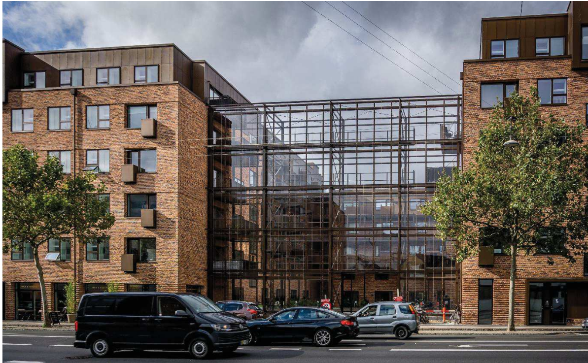
Figur 17. I denne nye bebyggelse, har man anvendt en støjskærm i åbningen mellem bygningerne for at opnå et lavt støjniveau i bebyggelsens gårdmiljø. I facaden mod vejen er der anvendt særligt støjdæmpende vinduesløsninger (Gl. Køge Landevej, København).
