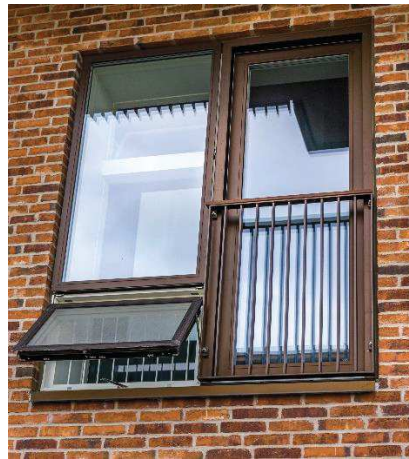
Figur 18. Støjdæpende multifunktionsvindue (billederne til venstre og i midten). Støjen dæmpes på vejen gennem åbningen for neden (udendørs) til åbningen for oven (indendørs). Til højre er vist en lydskodde, som er monteret foran et eksisterende vindue. Den dæmper støjen, men giver også adgang for frisk luft. Den kan desuden mørkelægge et rum, hvis det ønskes.
