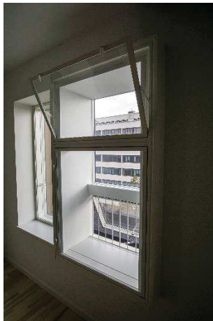
Figur 18. Støjdæpende multifunktionsvindue (billederne til venstre og i midten). Støjen dæmpes på vejen gennem åbningen for neden (udendørs) til åbningen for oven (indendørs). Til højre er vist en lydskodde, som er monteret foran et eksisterende vindue. Den dæmper støjen, men giver også adgang for frisk luft. Den kan desuden mørkelægge et rum, hvis det ønskes.
