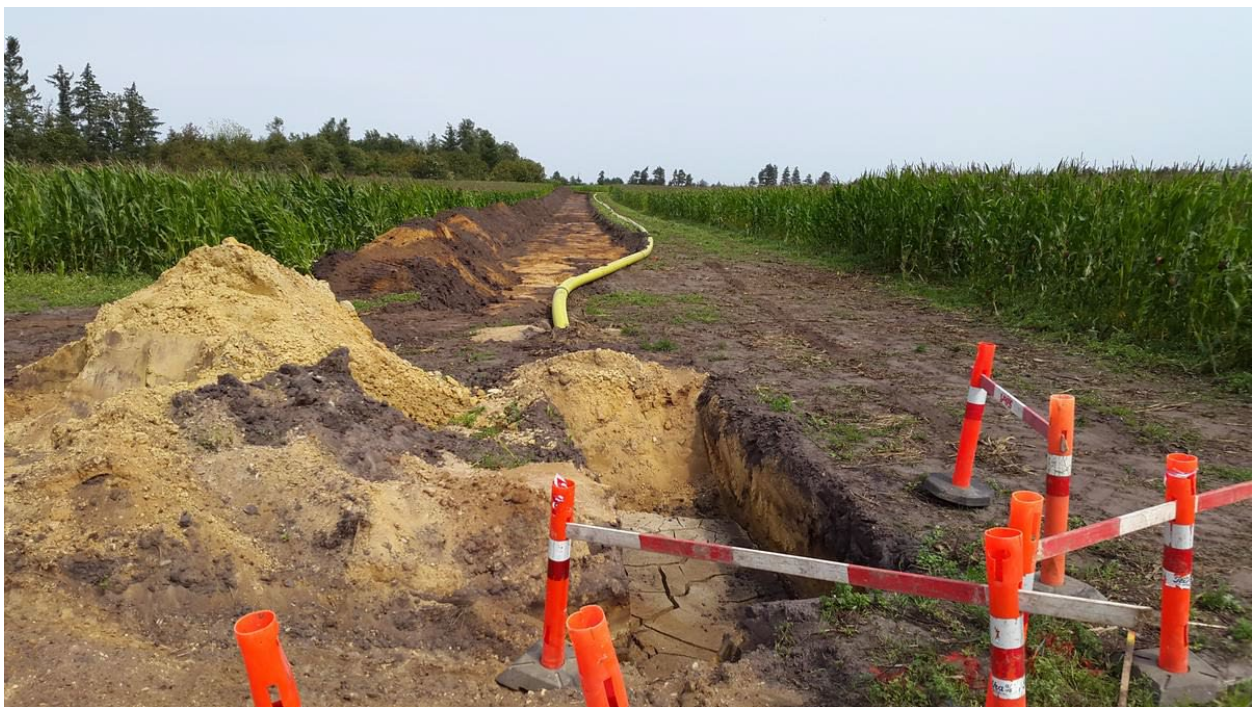
Figur 4 Eksempel på anlæggelse af gasledning i rørgrav.
