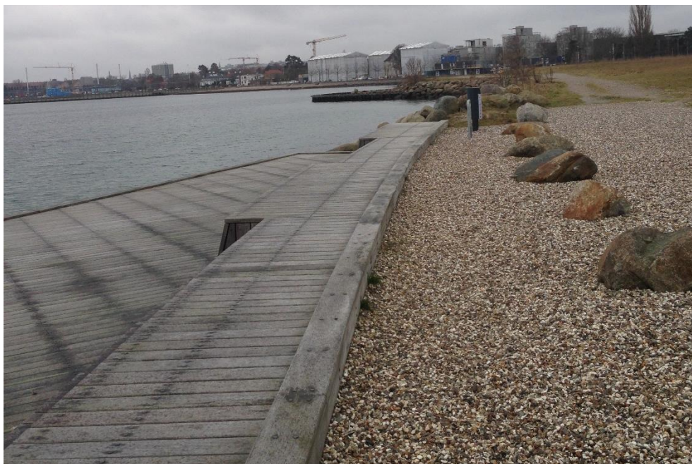
Figur 2.4 Eksisterende kyst og badebro ved Tuborg Syd set mod sydvest. Udløbet vil blive placeret under træbroen, som derfor skal fjernes midlertidig og gen-etableres efterfølgende.
