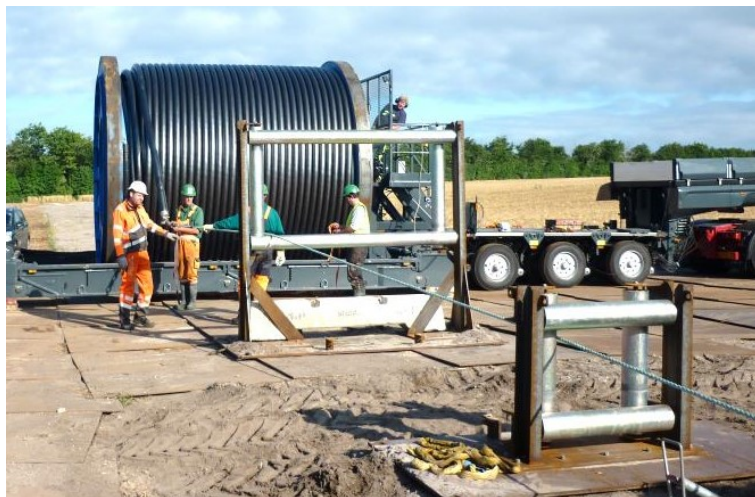
Figur 2-15 Kabeltromle på blokvogn
