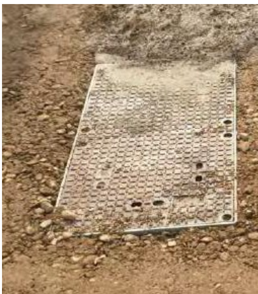
Figur 2-3 Eksempel på fiberbrønd i terræn
