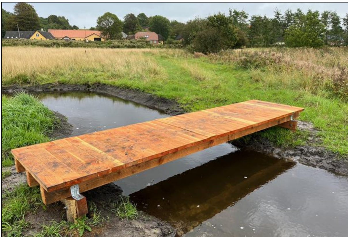
Figur 4-3 Eksempel på simpel træspang til fodgængere med cirka samme dimensioner, som projekteret i indeværende projekt.
