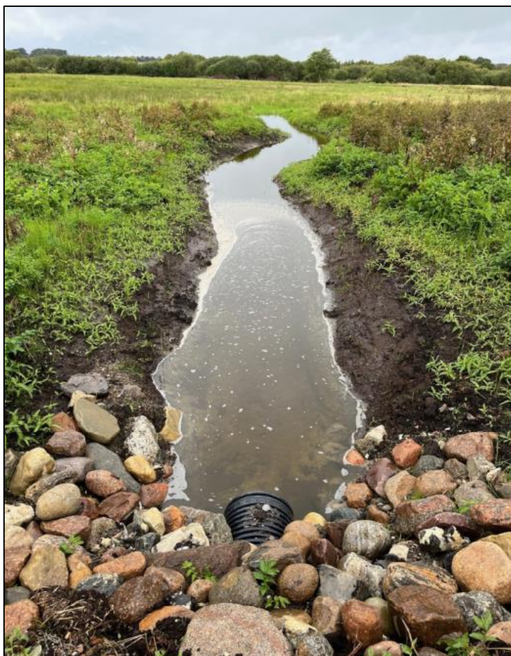
Figur 4-6 Eksempel på overrislingsgrøft med tilløb fra stort samledræn. Cirka 25 m nedstrøms løber vandet ud i engen uden at der forekommer stuvning ved røret.
