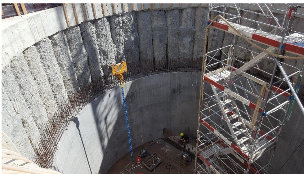
Figur 5.1 Skakt udført med sekantpælevægge.
