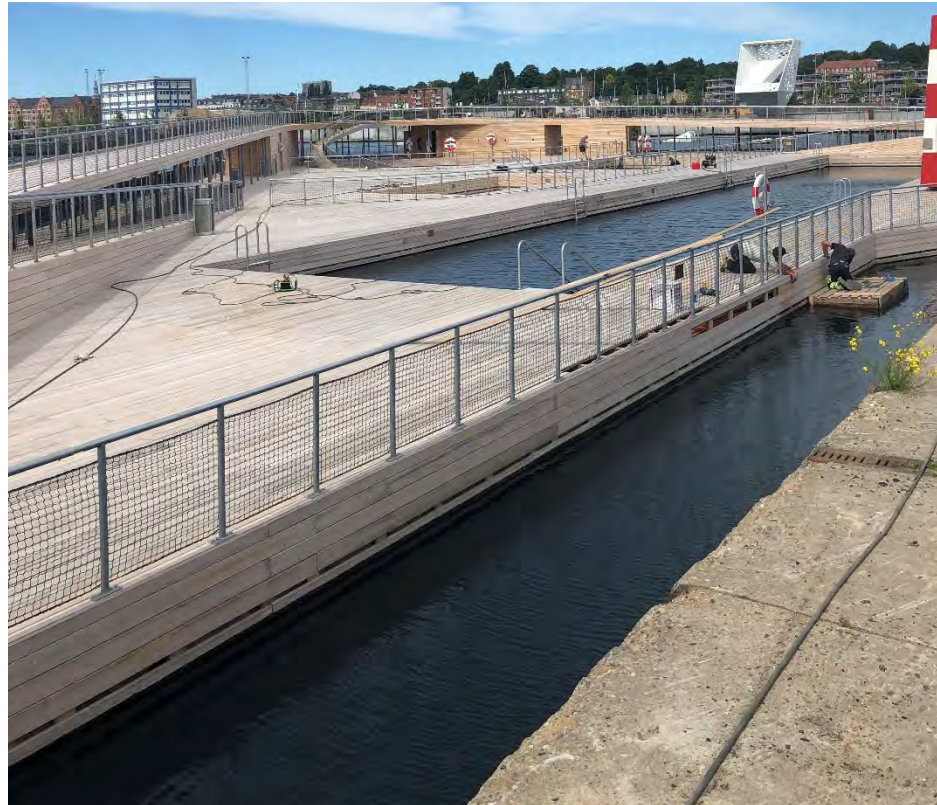
Princip for værn -varmgalvaniseret værn med sort fiskenet
