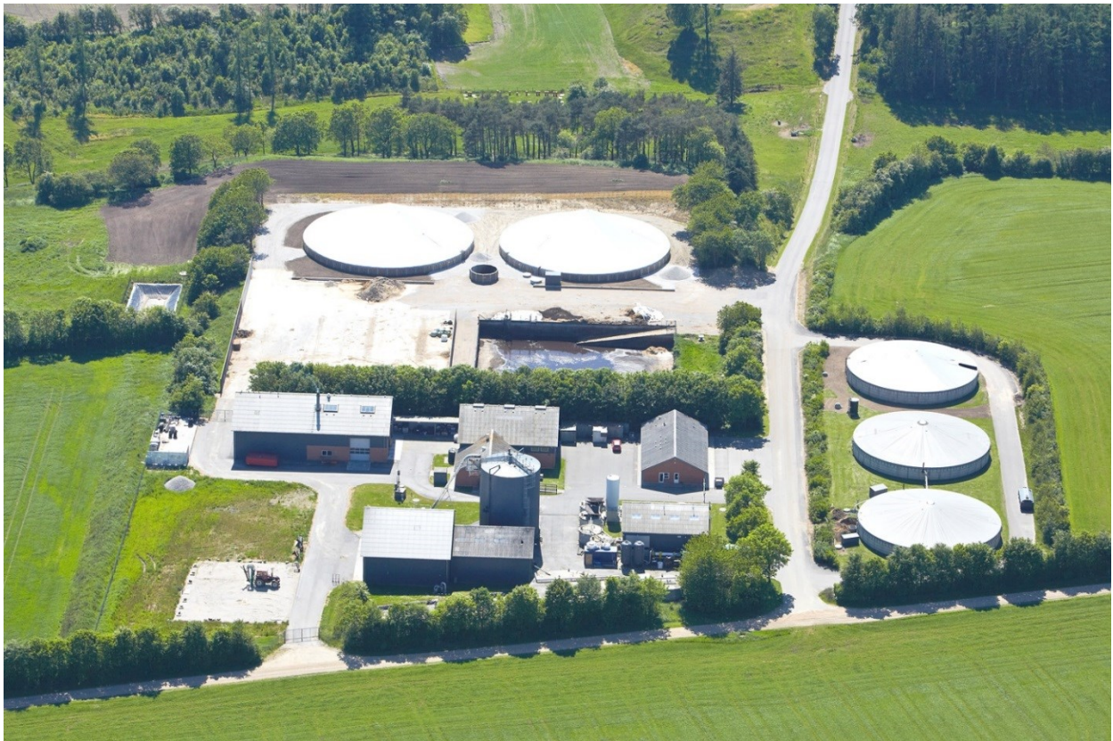
Figur 16.2: Skråfoto fra 2014 af eksisterende anlæg, set fra nordøst. Lagunen midt i anlægsområdet er i 2015 sløjfet og erstattet med en grusplads til opbevaring af brint mv.
