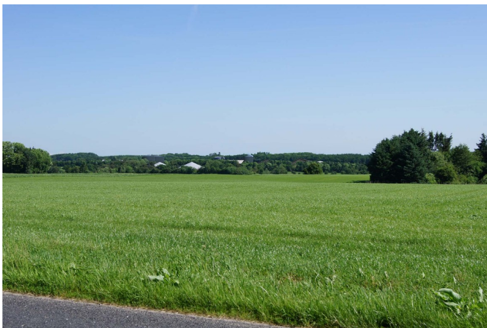
Billede 6.1 Eksisterende forhold, foto af biogasanlægget, set fra syd (bilag 16, foto-vinket 5).
