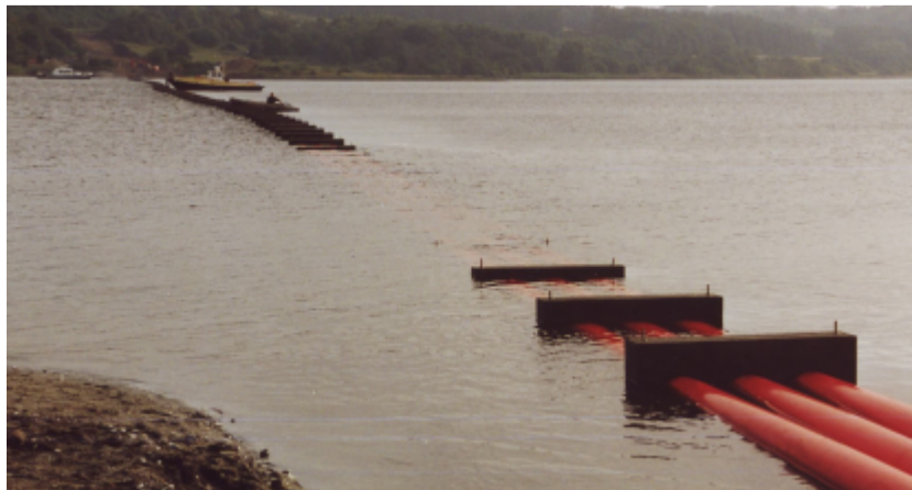
Fotos taget af JD Contractor i forbindelse med etablering af kabelrør ved nedspuling ved Katbjerg
