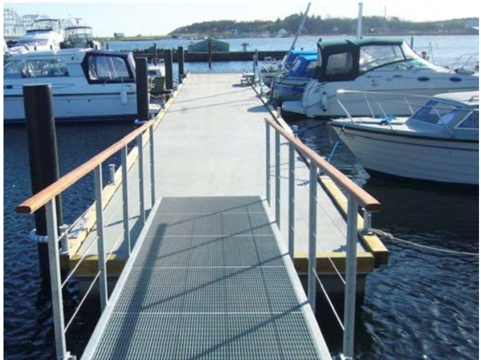
Figur 3-18: Eksempel på flydebro og landgangsbro
