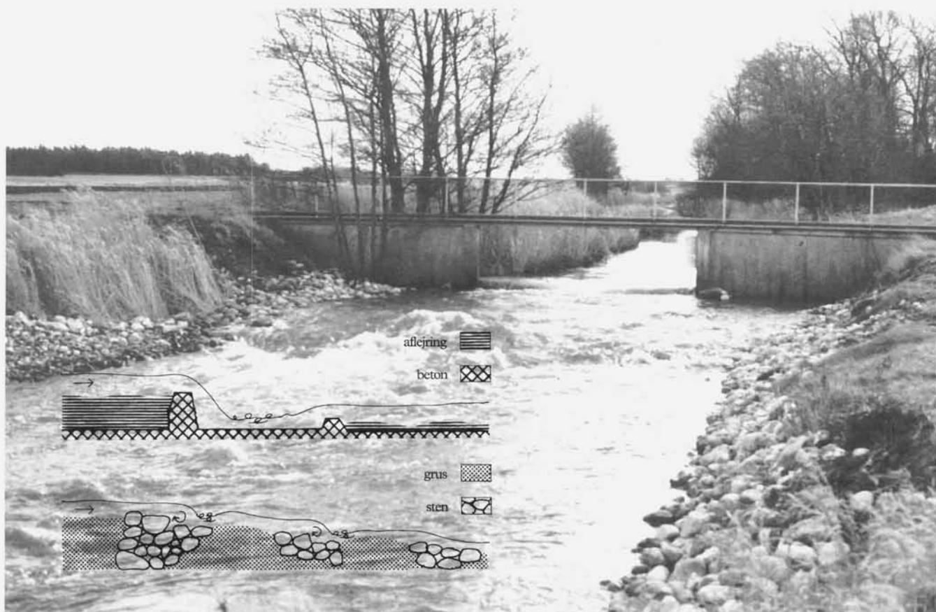
Figur 11.9. Reguleringsstyrt kan let og relativt billigt ombygges til stryg ved hjælp af sten og grus som vist på længdesnitte- ne. På fotografiet ses resultatet i virkeligheden. Foto: Ulrich Kern-Hansen
