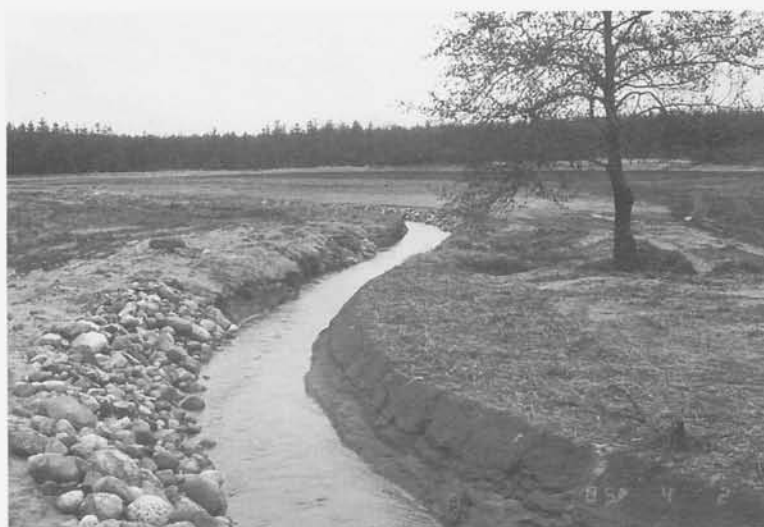
Figur 11.10. Vandløbsrestaurering: Plan for etableringen af et nyt slynget forløb i Stensbækken i Gram Kommune. Billedet er taget få måneder efter gravningen af det nye løb. Foto: Ulrich Kern-Hansen
