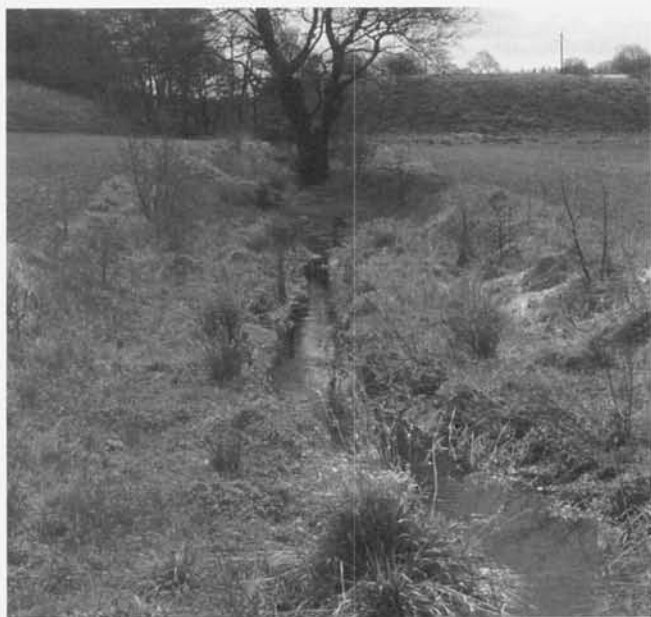
Figur 11.6. Elbæk, hvor dobbeltprofilet er etableret ved fjernelse af jord langs vandløbet. Foto. Ulrich Kern-Hansen
