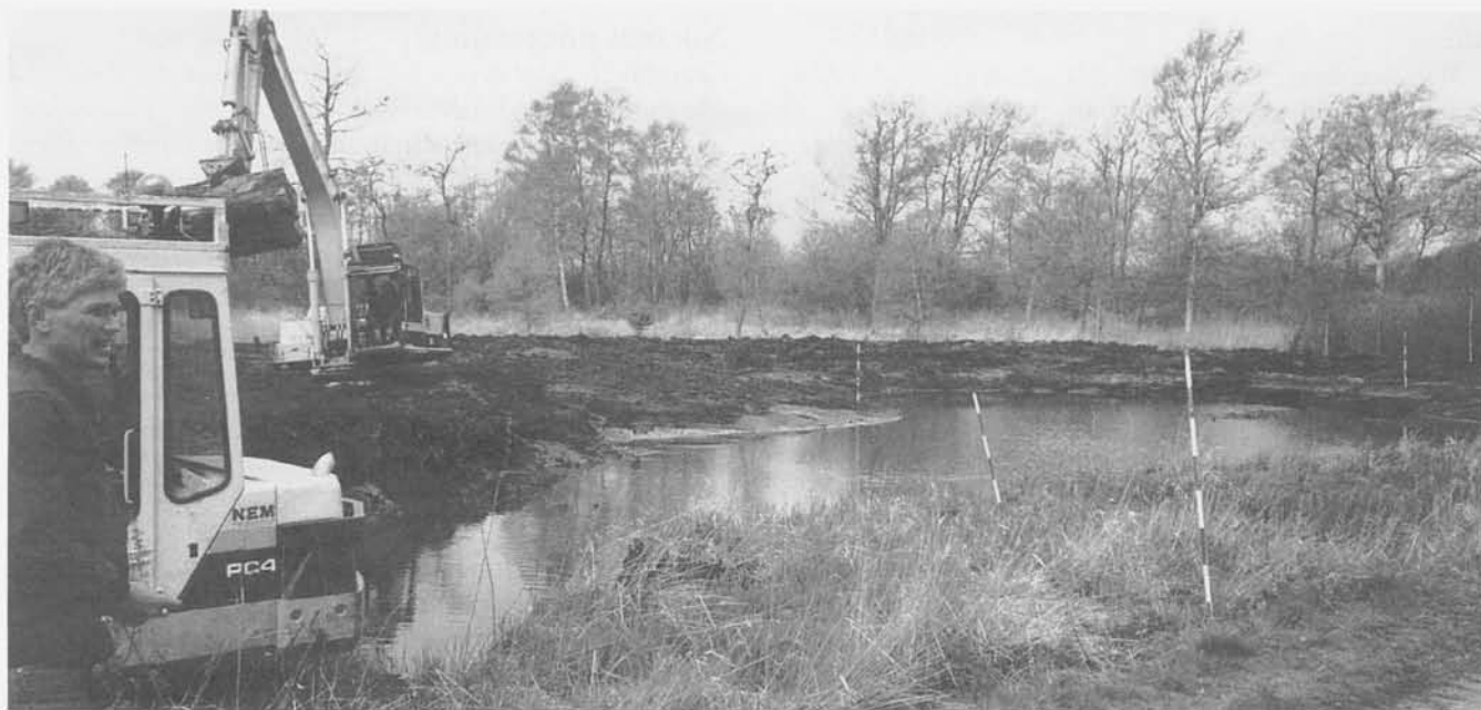
Figur 13.4. Nygravning af dam (ved Okkerhuset, Silkeborg Statsskovdistrikt). Føreren af gravkoen har nogle landmålerstokke at arbejde efter og er i øvrigt i forvejen instrueret om breddernes hældning og den ønskede dybde forskellige steder i dammen. Foto: Ole Juul Andersen
